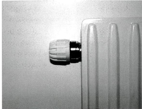
手動バルブの時には、お部屋が熱すぎたら少し右へ回して絞り、寒ければ左に回してバルブを開けて室温を調節してください。
