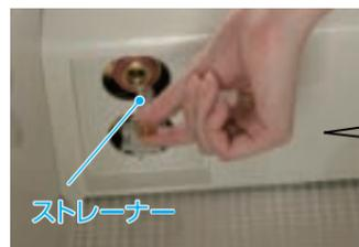
4 逆の手順でストレーナー、流量調節栓操作部を取り付け、流量調節栓を元の位置まで開きます。
