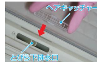
※ヘアキャッチャーの浮きがないようにツメを、とびら下排水口に取り付けてください。
