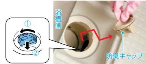
3 空気噴出しキャップを左(反時計回り)に回して、取り外します。
