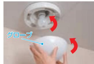
3 ランプを取り外し、新しいランプ(白熱ランプ)に交換します。
